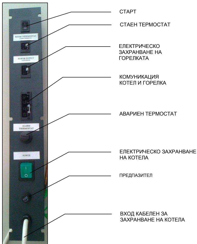
Фигура 11. Електрическо табло за управление на котела
