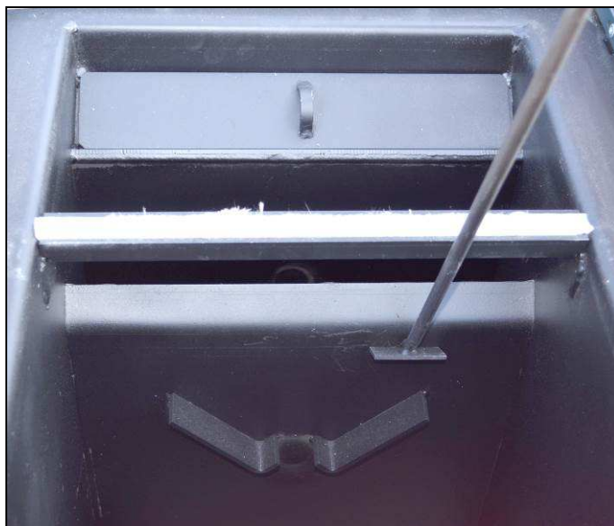
Фигура 6.2. Почистване на пепелта от стените на котела.
