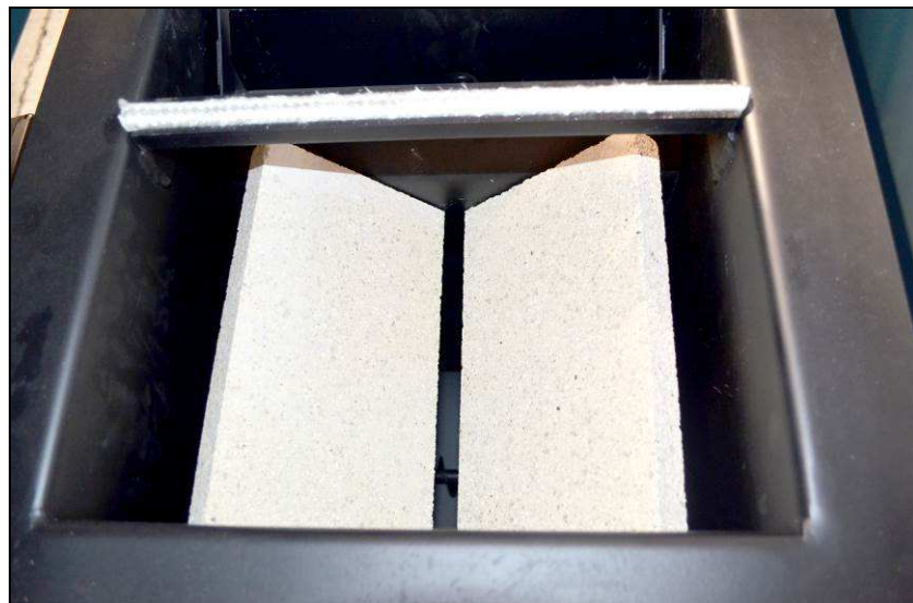
Фигура 5.4. Монтаж на шамотните елементи в печната камера на котела.
