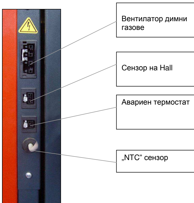
Фигура 6.3. Означение на електрическите конектор, монтирани на интерфейсия панел на котела.
