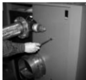
Болтово съединяване на задните облицовъчни листове към лятия заден елемент
