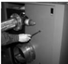
Болтово съединяване на задните облицовъчни листове към лятия заден елемент
