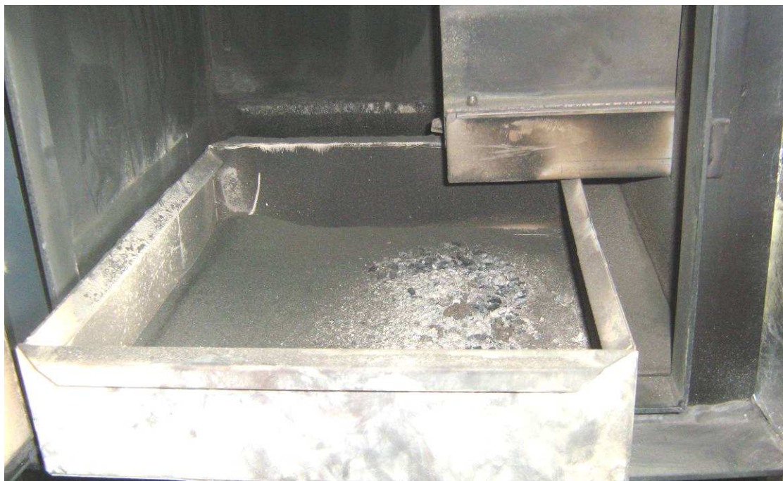
Фигура 2.16. Изваждане на контейнера за пепелта от пещната камера на котела;
