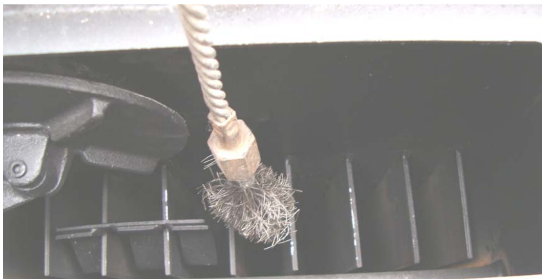
Фигура 5.19. Почистване пепелния остатък, наптрупан по повърхностите на конвективния тракт на котела с телена четка;
