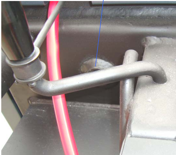
Фигура 4.4. Изглед към щуцера на котела за монтаж на гилзата за сондата на термовентила за аварийно охлаждане на котела;
