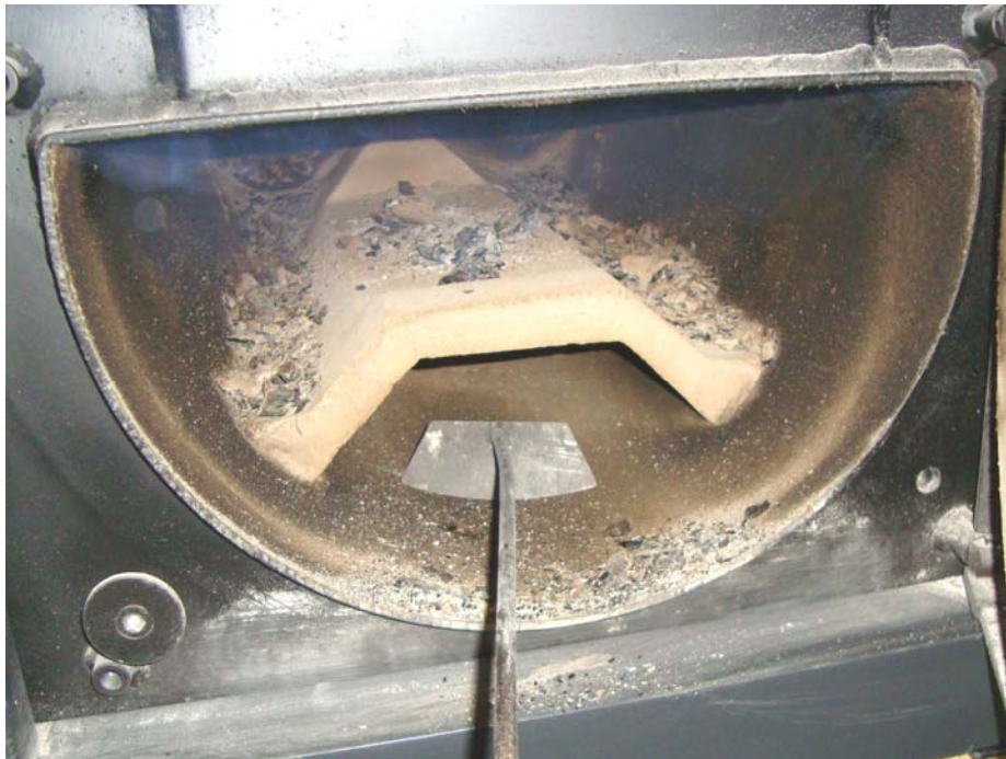
Фигура 5.13. Почистване на пещната камера на котела от пепелния остатък и неизгорели въглени с помощта на греблото;
