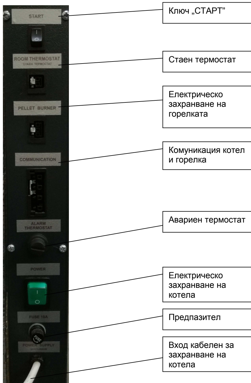
Фигура 7. Електрическо табло за управление на котела, при работа на дървесни пелети
