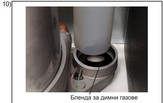
8) След премахването на горния капак на корпуса развийте блокиращия винт на димоотводната тръба
