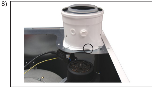
8) След премахването на горния капак на корпуса развийте блокиращия винт на димоотводната тръба
