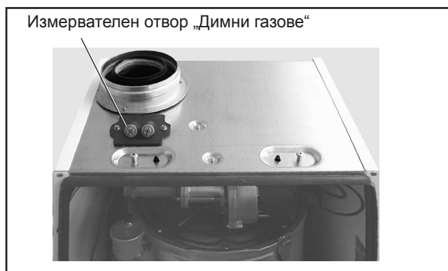
Снимка: Измерване на димни газове при отворен котел
