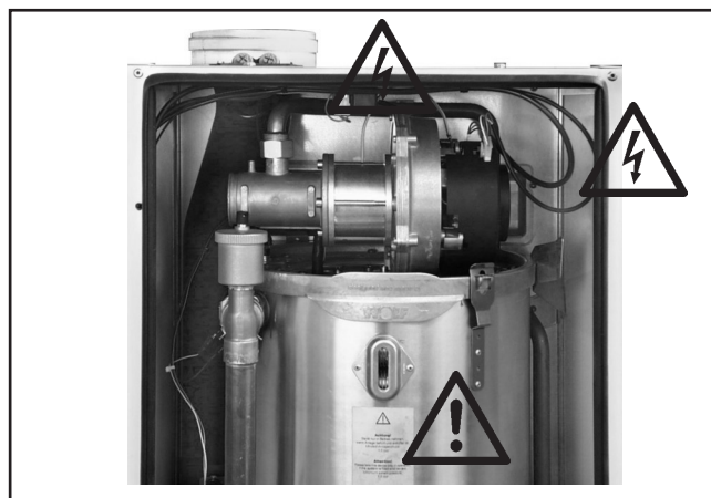
Снимка: Запалителен трансформатор, запалителен електрод високо напрежение, топлообменник Опасност от електрическо напрежение, Опасност от изгаряне с горещи елементи
