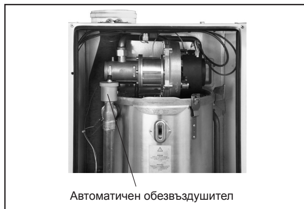
Снимка: Автоматичен обезвъздушител
