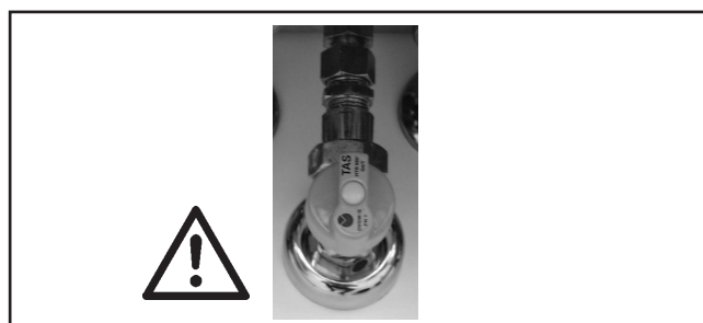
Снимка: Връзка за газ Опасност от отравяне и експлозия поради изтичане на газ
