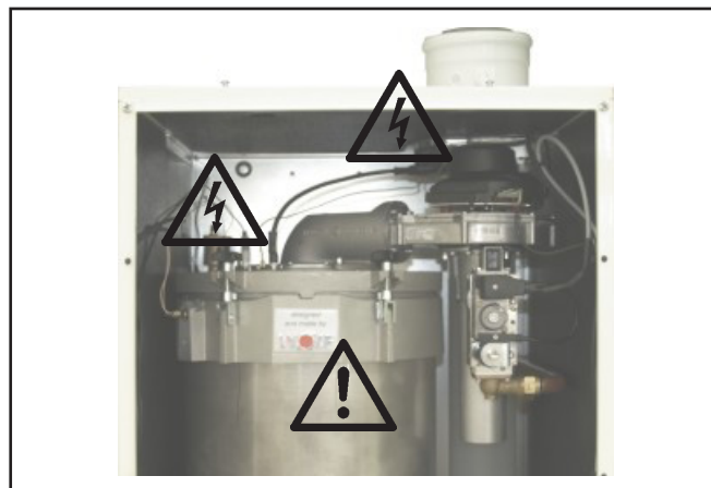
Снимка: Запалителен трансформатор, високо напрежение- запалителен електрод, топлообменник Опасност от електрическо напрежение, опасност от изгаряне с горещи елементи
